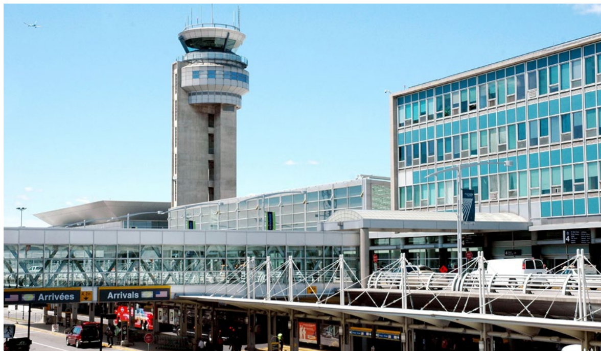
Terminal de l'aéroport international Pierre-Elliott-Trudeau de Montréal
